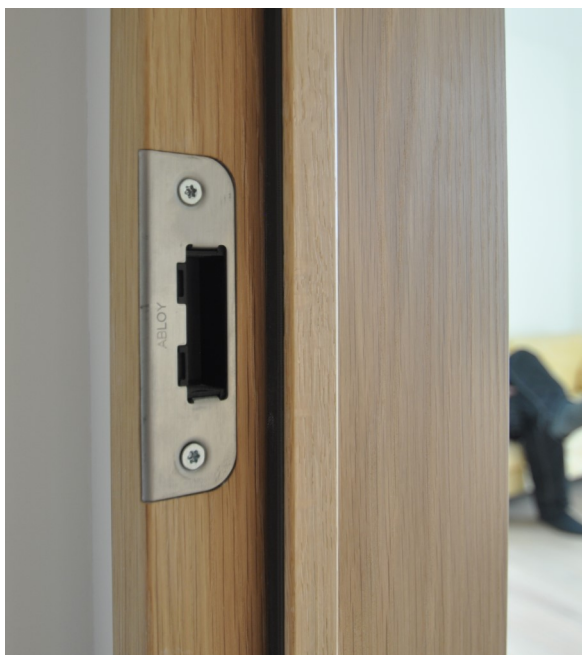
Sluttstykke 0055 børstet rustfri. Brun dempelist i karmen som gir en behagelig lukkelyd.
