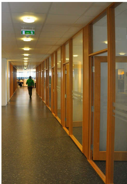
Korridor med glassveggfronter og dørblad i eik finer.
