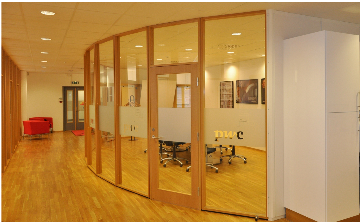
Buet glassvegg med våre dørblad i eik finer. Standard glassåpning 20cm brystningshøyde med 33.1 glass.
