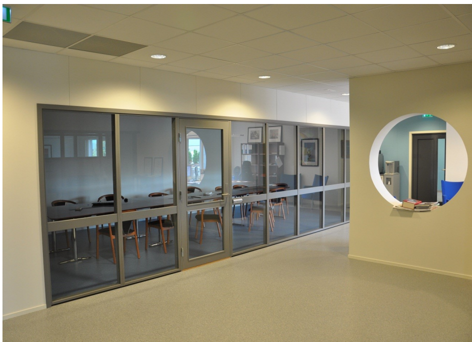
Malt dørblad til møterom. 35dB utførelse, med 2stk glass og losholt tilpasset glassveggen.
