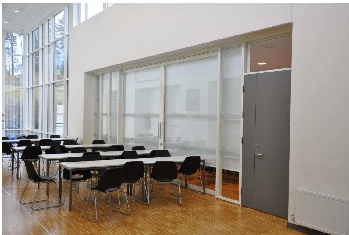
To-fløyet dør montert i glassvegg.
